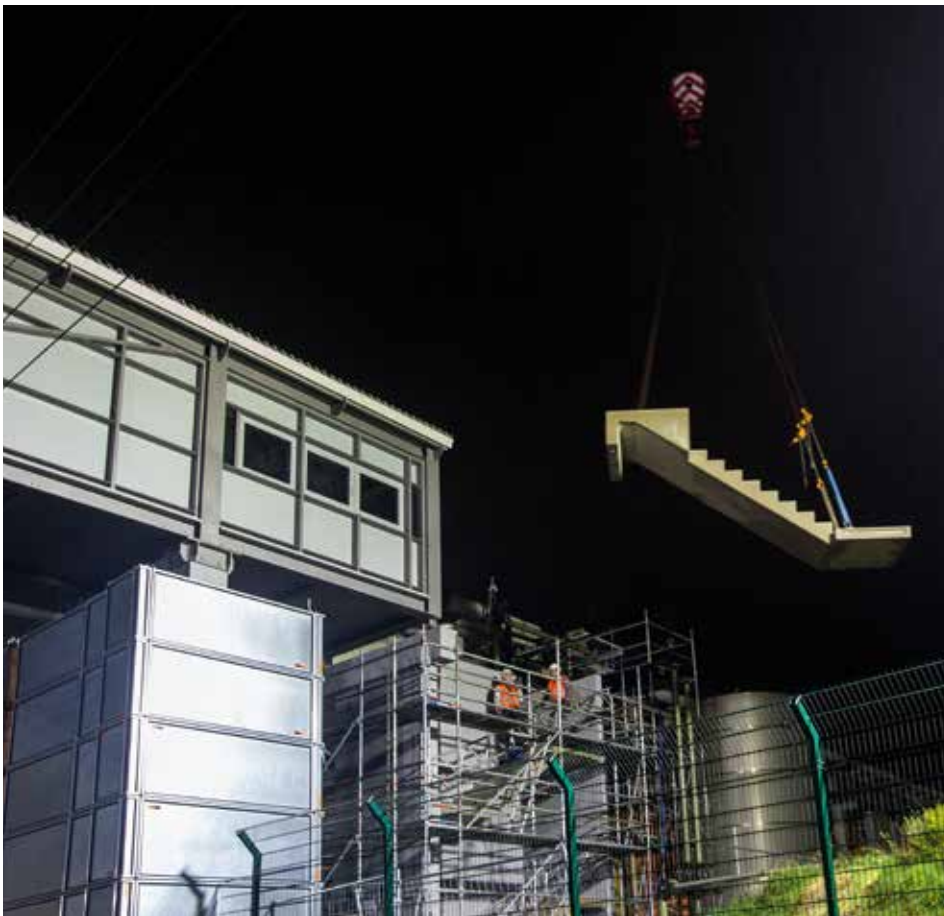
Einhub des Treppenabsatzes.
