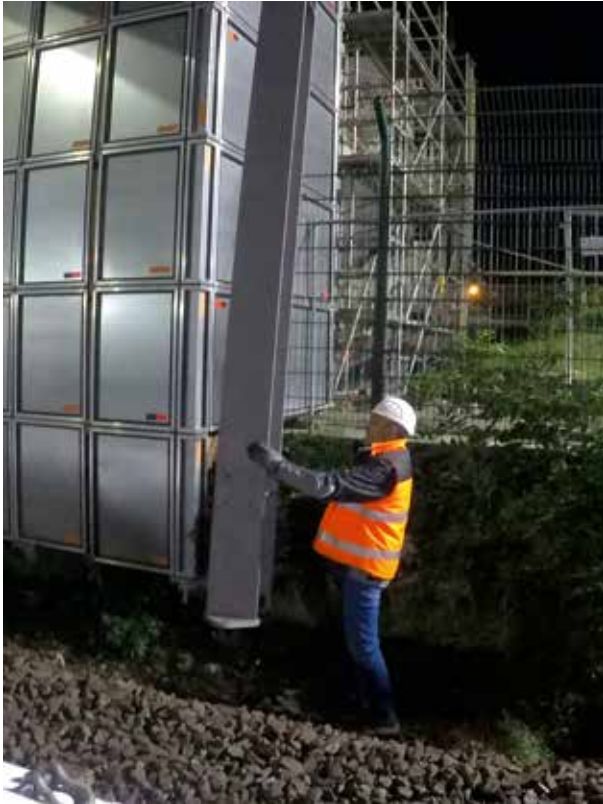
Dirigieren einer Unterzug-Traverse.
