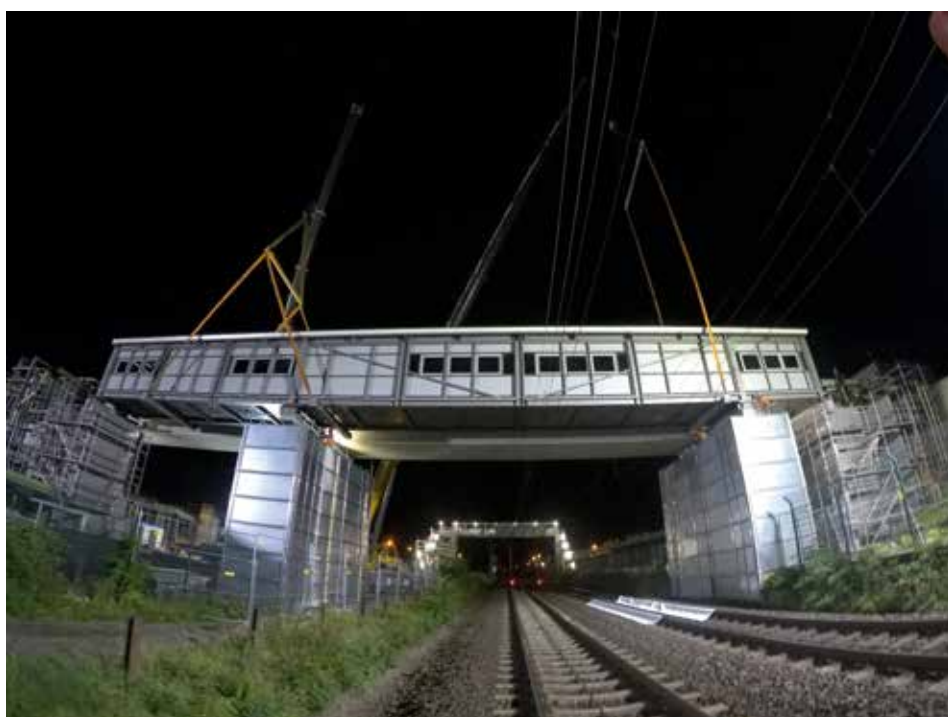
Die neue Fußgängerbrücke über der ICE-Strecke.
