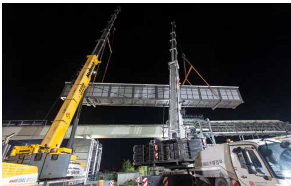
Einhub des Brückenüberbaus.
