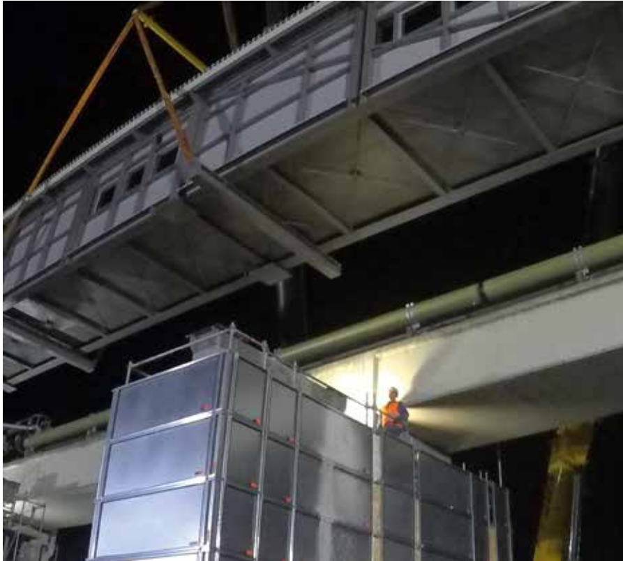
Einhub des Brückenüberbaus.
