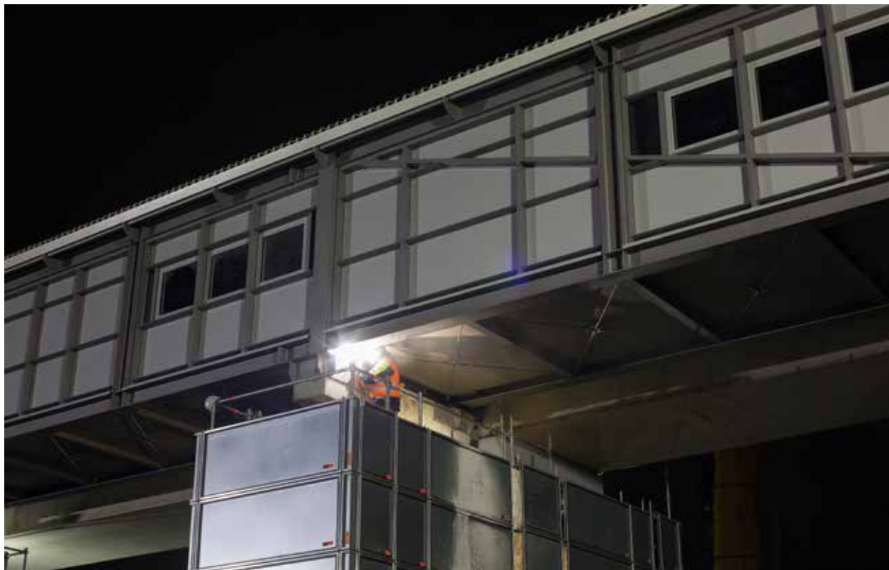
Verschweißen der Brückenlager durch Thomas Eisenreich.
